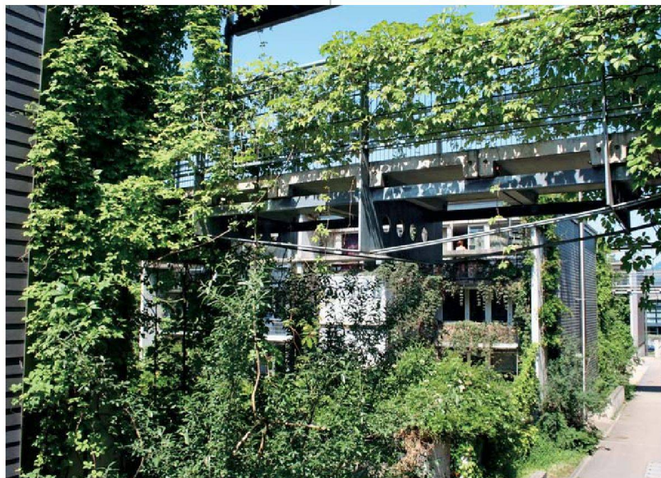
Fassaden, Laubgänge, Terrassen: überall rankt und wuchert es.
