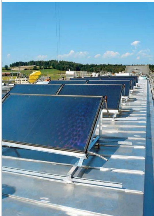
Die Solaranlage umfasst 120 Flachkollektoren.
