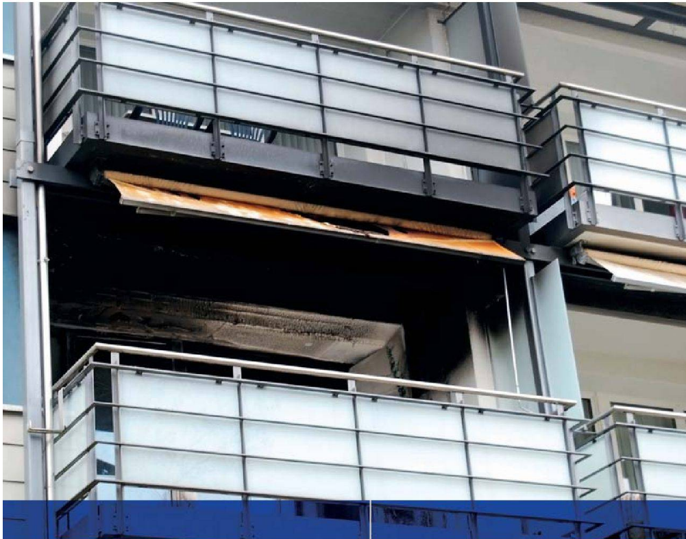
So präsentierte sich der Balkon der Rümlanger ASIG-Wohnung nach dem Brandfall. Ein Kurzschluss an einem Elektrogerät hatte ihn ausgelöst.
