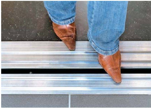
Die Anhaltegenauigkeit eines Lifts ist ein wichtiges Kriterium für die Sicherheit.
