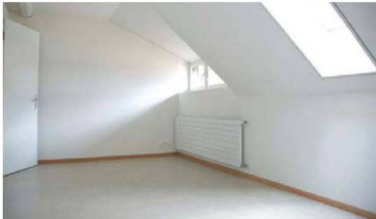
Einblick in eine Dachwohnung mit geschliffenem Betonboden.
