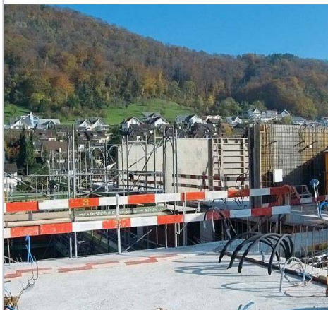
In Lausen (BL) schuf die Gemeinde mit der Gründung der Seniorengenossenschaft Lausen dringend benötigten altersgerechten Wohnraum.
