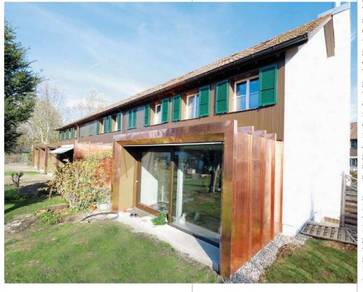
Blick auf die Eingangsseite: Die Häuser erhielten eine 13 Zentimeter dicke Wärmedämmung.
