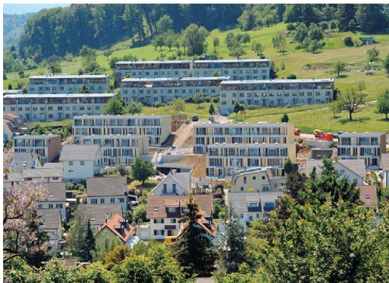
Die sechs unterschiedlich grossen Blöcke der Siedlung Leimenmatt befinden sich zwischen Einfamilienhäusern (unterhalb) und einer grossen Reihenhaussiedlung (oberhalb).
