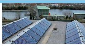
Leistungsstarke Vakuumröhrenkollektoren erstellte die EBG beider Basel auf dem Dach ihres Hochhauses in Birsfelden.
