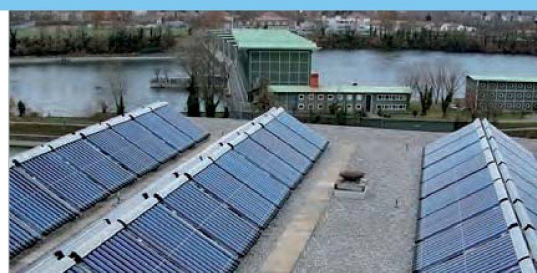
Leistungsstarke Vakuumröhrenkollektoren erstellte die EBG beider Basel auf dem Dach ihres Hochhauses in Birsfelden.
