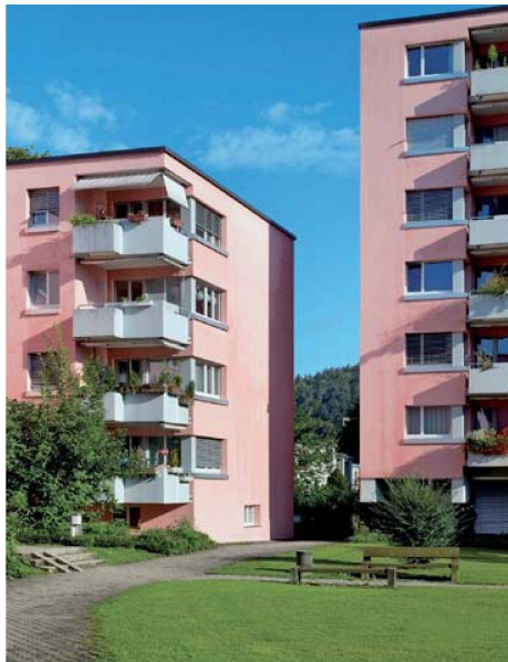
Die Totalsanierung von 128 bewohnten Wohnungen erforderte eine straffe Planung. Die Arbeiten in den Wohnungen wurden strangweise durchgeführt, pro Strang standen vier Wochen zur Verfügung.
