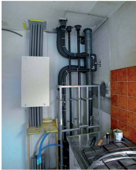
Da die alten Leitungen einbetoniert waren, mussten neue Steigzonen geschaffen werden.
