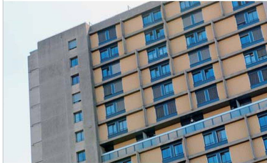
Die Leichtbauteile an der Nordfassade versah man mit Brandschutzplatten, Dämmungen und einer neuen Verkleidung.
