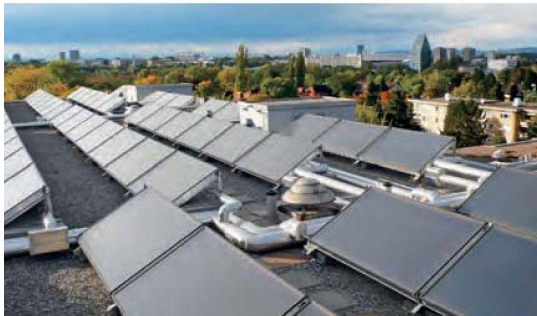
Die Solaranlage zur Warmwasseraufbereitung bedeckt eine Dachfläche von 200 Quadratmetern.
