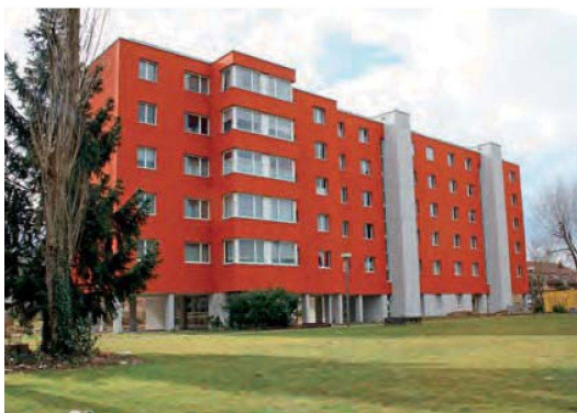
Die beiden Hochhäuser erhielten Küchenanbauten (links).
