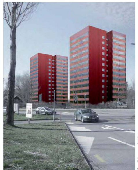
Die beiden Hochhäuser (links: heutiger Zustand) werden mit einer roten Metallfassade eingekleidet.
