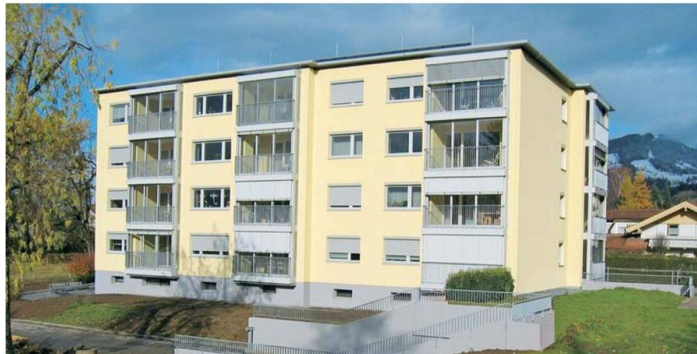
minimieren. Eine der wichtigsten Massnahmen war deshalb der Einbau einer Komfortlüftungsanlage mit einer Wärmerückgewinnung von über 85 Prozent. In jedem der fünf Doppelhäuser ist im Dachstock ein Technikraum für das zentrale Lüftungsgerät reserviert. Die Aussenluftansaugung und Wegführung der Abluft erfolgen über das Dach. Der Volumenstrom ist von der Zentrale aus regelbar, die Bewohner haben jedoch in den Wohnungen gewisse Bedienungsmöglichkeiten.
