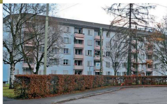
Die Südfassade erhielt eine neue Verkleidung und verglaste Balkone (klein: früherer Zustand).
