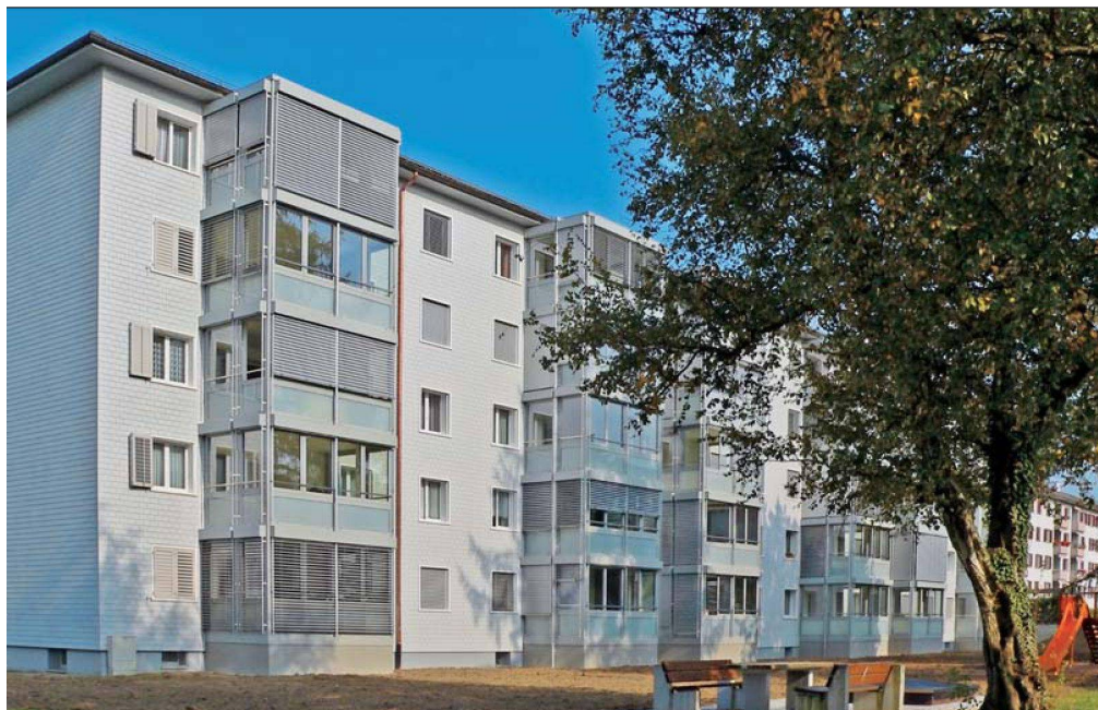
Die Südfassade erhielt eine neue Verkleidung und verglaste Balkone (klein: früherer Zustand).
