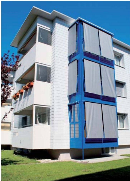
Die Siedlungsgenossenschaft Winterthur und Umgebung liess ihr Haus an der Auwiesenstrasse in Rätterschen nicht nur nach Minergie sanieren, sondern sorgte gleichzeitig mit Erkeranbauten für grössere Wohnzimmer und mehr Licht.
