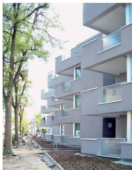
Die Siedlung Gladbachstrasse von der Strassenseite. Beim neuen Aussenputz handelt es sich um ein ökologisches System, das ohne Biozide auskommt.
