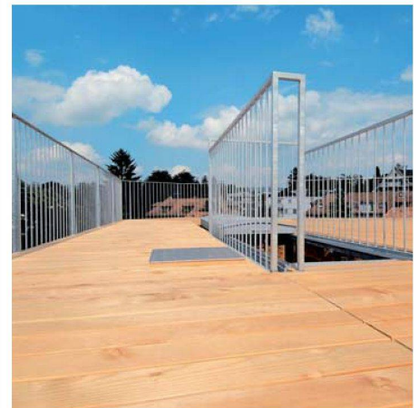
Die Ausstiegsluken mussten mit Schutzgeländern versehen werden.
