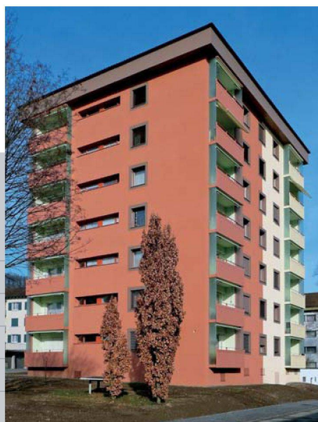
Die neue Kompaktfassade bietet zeitgemässen Wärmeschutz.
