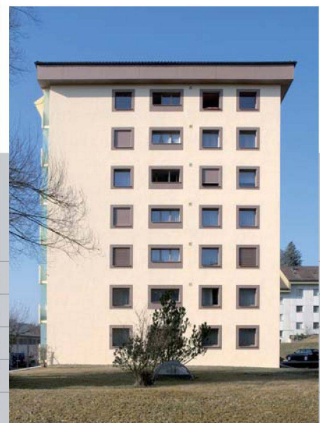
Die braunen Fenstergewände lehnen sich an die ursprüngliche Farbe des 1960er-Hauses.
