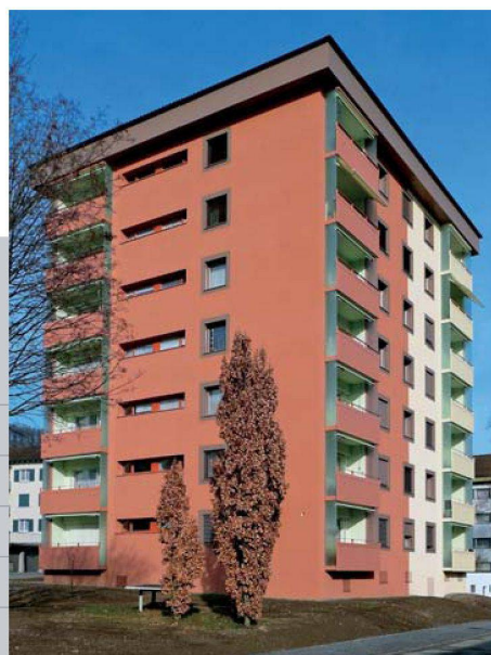
Die neue Kompaktfassade bietet zeitgemässen Wärmeschutz.
