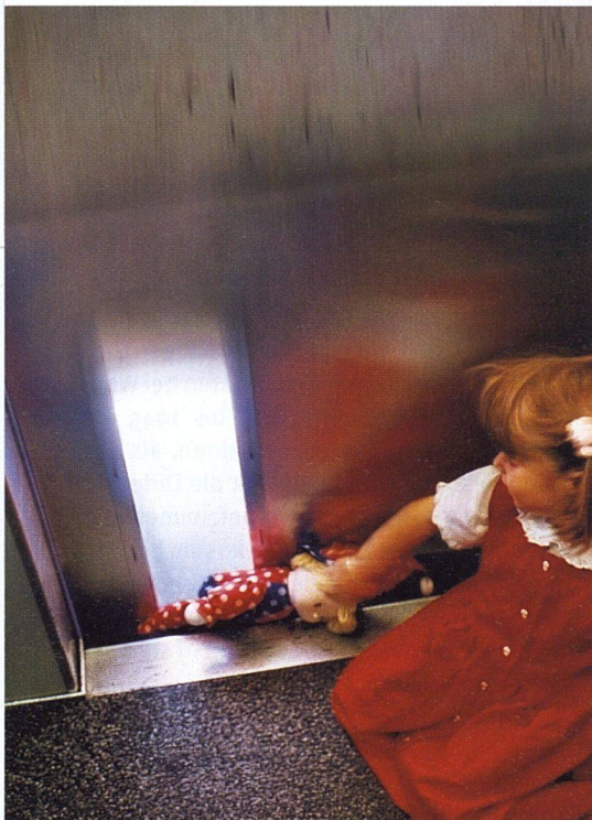
Lifte ohne Kabinenabschluss bergen grosse Unfallgefahr.
