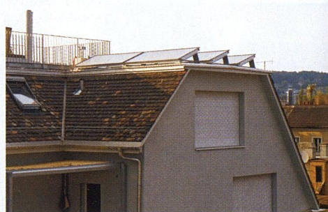
Die Wogeno Zürich baute ein Stadthaus von 1878 so um, dass es den Minergiestandard deutlich unterbietet.
