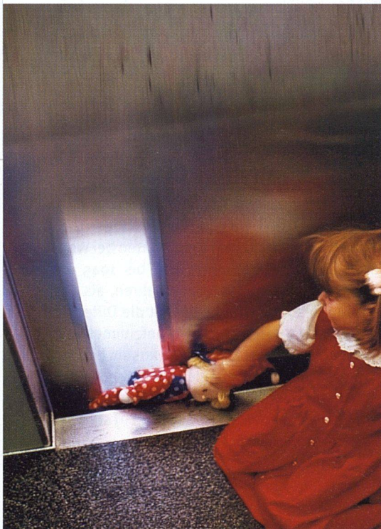
Lifte ohne Kabinenabschluss bergen grosse Unfallgefahr.
