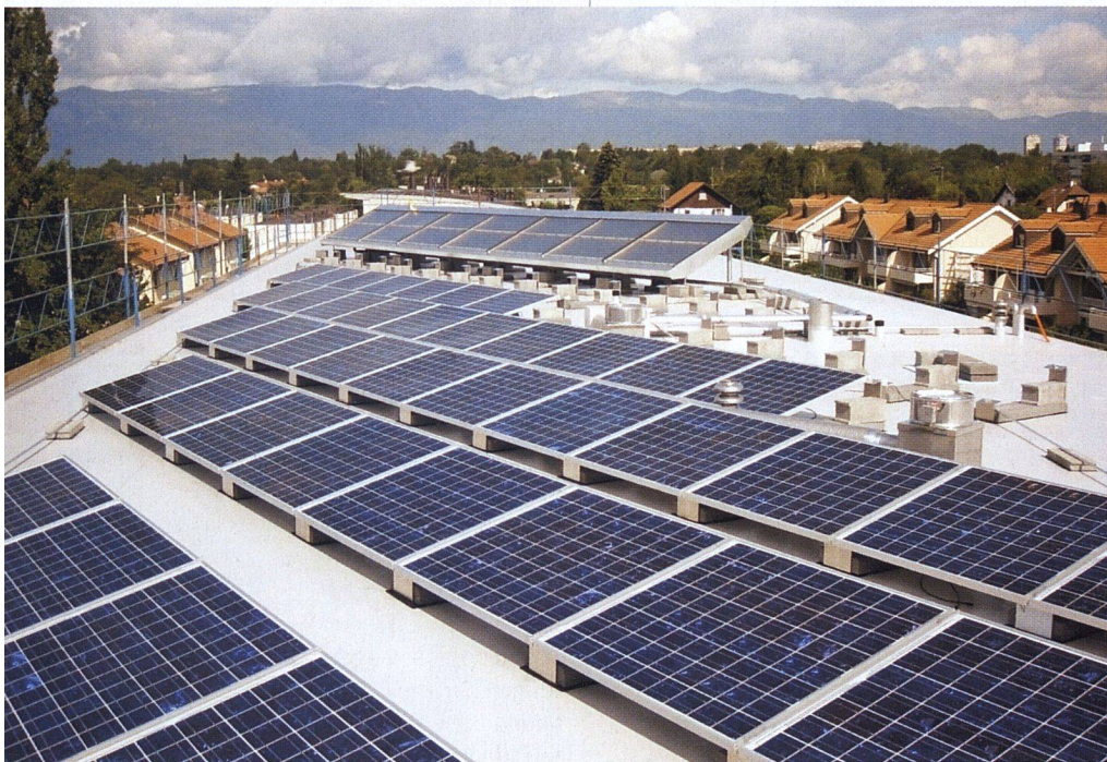
Der Neubau der Genfer Baugenossenschaft Codha zeichnet sich unter anderem durch seine 100-Quadratmeter-Fotovoltaikanlage aus.
