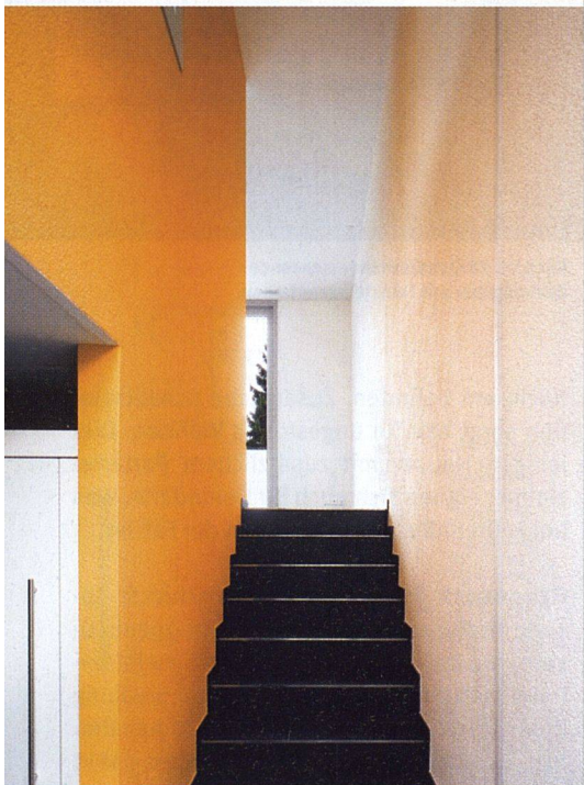
Das Treppenhaus besitzt ein fast geschosshohes, längs angeschlossenes Fenster, das viel Licht in den ersten Stock bringt. Dank einem Innenfenster zum Treppenhaus profitiert davon auch das Bad im ersten Stock.
