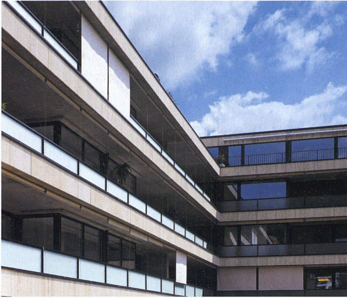
Starke Betonung der Horizontalen: Travertinfassade und durchlaufende Brüstungsbänder prägen die Fassaden.
