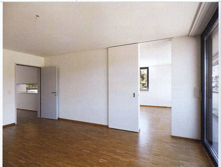
Teils raumhohe Türen und Eichenparkett kennzeichnen die Wohnräume.
