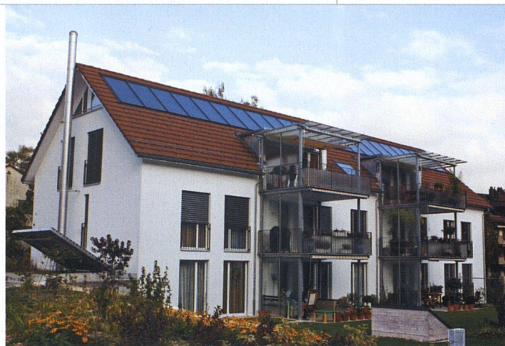
Eines der vier Mehrfamilienhäuser der WGW-Siedlung Haspel in Kollbrunn. Solarkollektoren auf dem Dach sind Teil der ökologisch vorbildlichen Wärmeversorgung.
