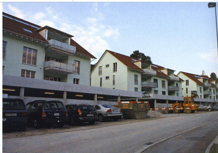
Die vier am Hang gelegenen Häuser der WGW-Siedlung Haspelrain. Auf Strassenniveau ist eine durchgehende Vorhalle eingerichtet, die zu den Garagen führt. Auf ihrem Dach befinden sich die Sitzplätze der EG-Wohnungen.
