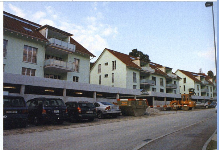
Die vier am Hang gelegenen Häuser der WGW-Siedlung Haspelrain. Auf Strassenniveau ist eine durchgehende Vorhalle eingerichtet, die zu den Garagen führt. Auf ihrem Dach befinden sich die Sitzplätze der EG-Wohnungen.
