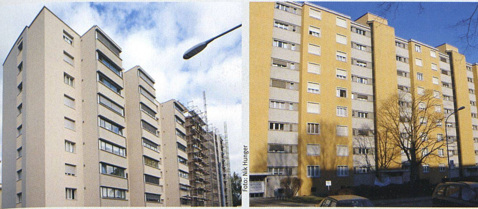
Die neuen Anbauten greifen nicht allzu stark in die bisherige Optik der Fassade ein (Bild rechts), sondern verstärken das vorhandene Relief einfach in der Tiefe.
