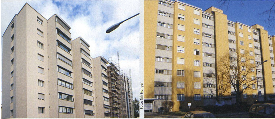
Die neuen Anbauten greifen nicht allzu stark in die bisherige Optik der Fassade ein (Bild rechts), sondern verstärken das vorhandene Relief einfach in der Tiefe.
