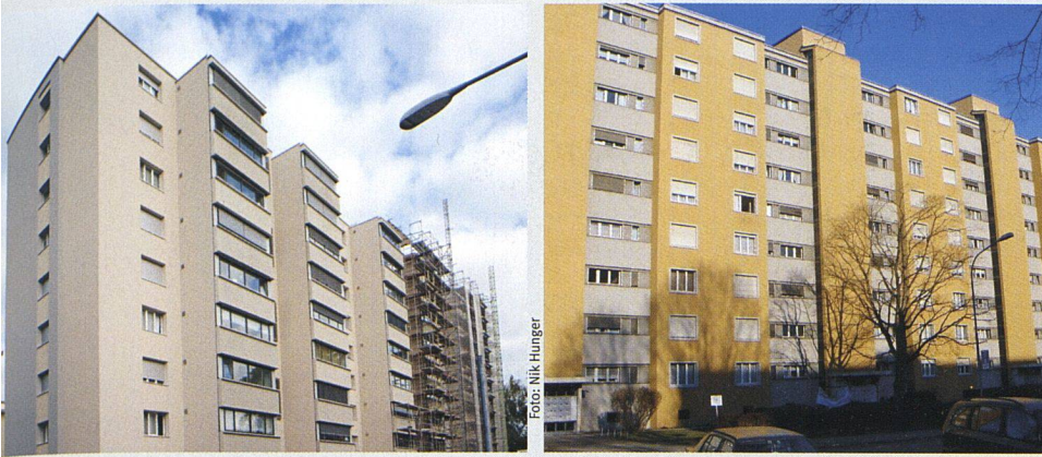
Die neuen Anbauten greifen nicht allzu stark in die bisherige Optik der Fassade ein (Bild rechts), sondern verstärken das vorhandene Relief einfach in der Tiefe.
