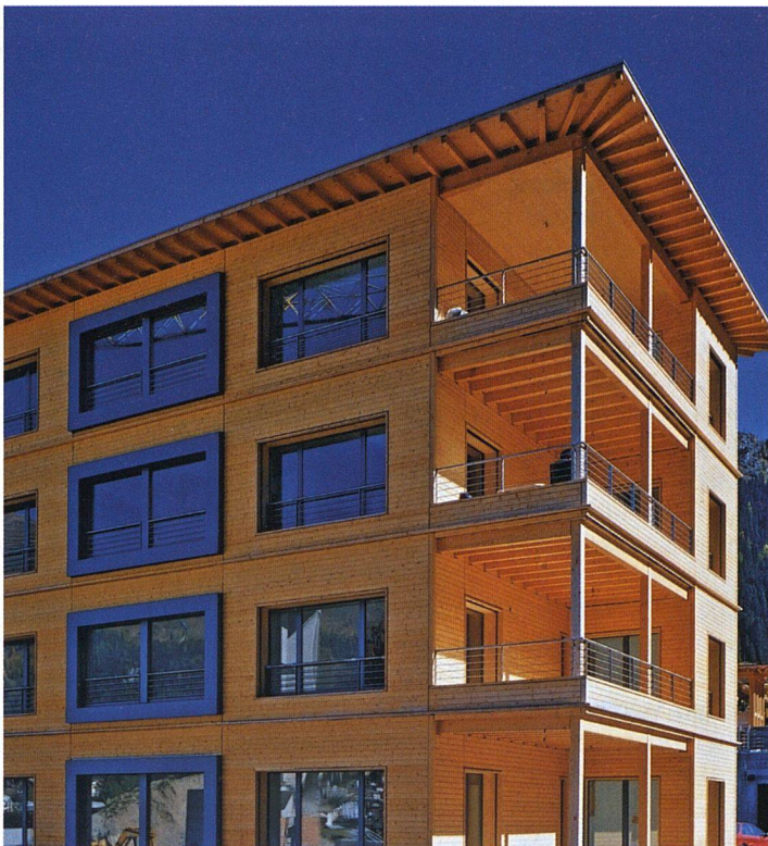
Grosse Fensterflächen bieten diese Holz-Metall-Fenster bei einem privaten Mehrfamilienhaus in Davos. Sie weisen einen hohen Wärmeschutzwert auf und sind Minergie-vorzertifiziert, wodurch der Aufwand für dieses Gütesiegel verringert wird.
