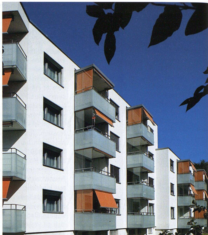
Bei der Minergie-Sanierung der Siedlung Mattacker in Zürich Seebach galt es ebenfalls, den Schallschutz zu verbessern. Die ASIG entschied sich für Fenster und Balkon-Hebeschiebetüren aus Holz-Aluminium mit einem U-Wert von 1,0 W/m 2 K.
