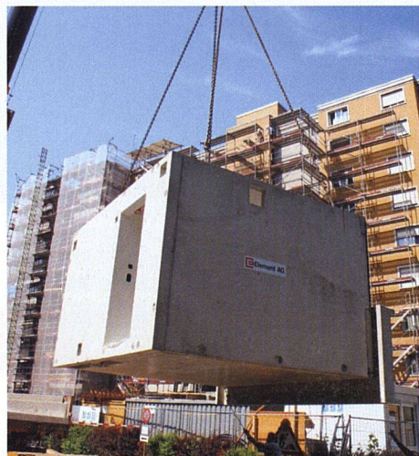
10:00 Uhr: Ein Raumelement wird angehoben ...
