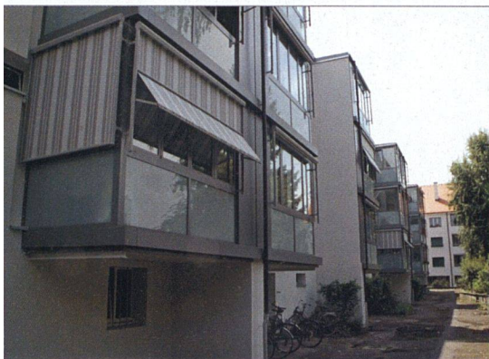
Die neuen Wintergärten sind energetisch sinnvoll und schaffen eine willkommene Vergrößerung der Wohnungen.
