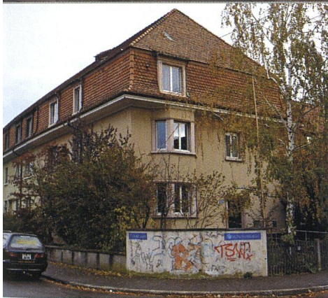
Liegenschaften der Wohngenossenschaft Morgartenring vor und nach der Renovation. Die Häuser erhielten eine 10-cm-Wärmedämmung.
