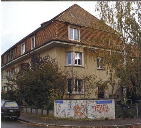
Liegenschaften der Wohngenossenschaft Morgartenring vor und nach der Renovation. Die Häuser erhielten eine 10-cm-Wärmedämmung.
