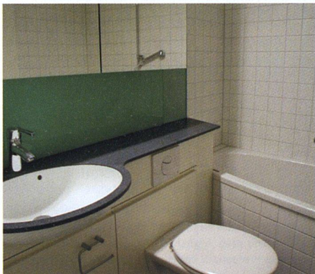
Alle Bäder wurden komplett erneuert. Pro Bad benötigte man nur zehn Arbeitstage.
