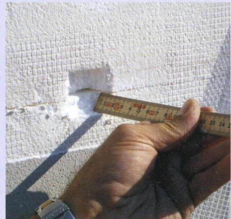
Vorsicht bei Kompaktfassaden: Massive Wärmeverluste und Schimmel können auftreten, wenn in Zwischenräumen Dampf kondensiert.
