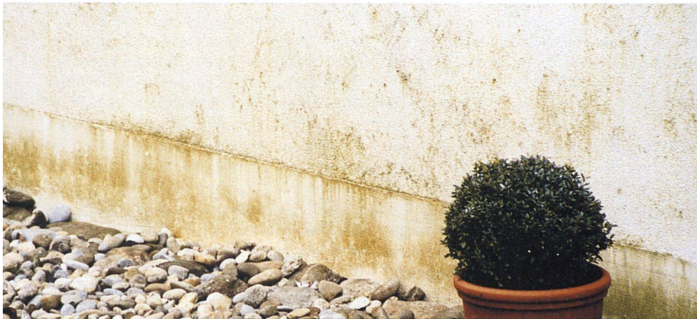
Algenbewuchs ist insbesondere bei gut gedämmten Fassaden ein Problem. Vom Einsatz von Fungiziden rät der Experte jedoch ab, da sie nicht mehr als eine Symptombekämpfung sind.
