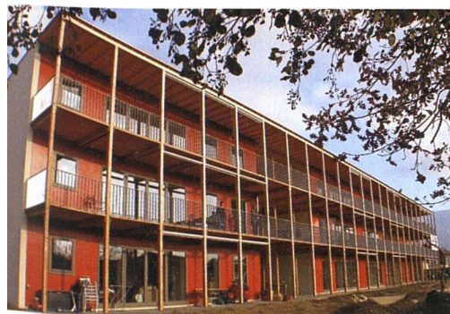
Eine knallrote Fassade und durchgängige Laubengänge verleihen den langen Baukörpern ein unverwechselbares Gesicht.
