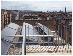
Sonnenkollektoren auf dem Dach erwärmen im Sommer bis zu 80 Prozent des Warmwassers.
