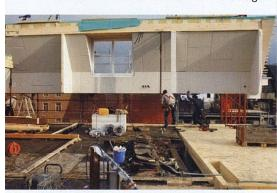
Die neuen Dachgeschosse wurden in Holzelementbauweise vorfabriziert und in einem einzigen Tag auf das Gebäude gesetzt.
