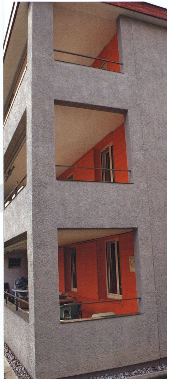
An der Fuge ist der neue Teil erkennbar.
