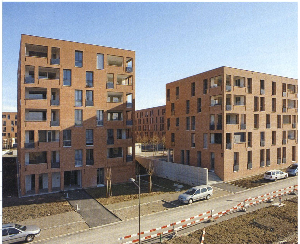
Trotz der grossen Fensteröffnungen und Loggien machen die Fassaden einen mural geschlossenen Eindruck.
