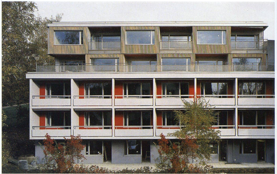
Bei der Siedlung Irchel schaffte die SAW mit Aufstockungen mehr Platz.
