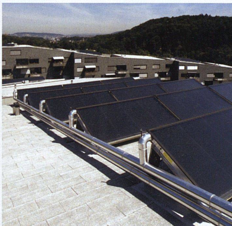
Bei der Siedlung Vistaverde (BG Freiblick und Zurlinden) heizt man mit Holzschnitzeln. Solarzellen übernehmen einen Grossteil der Warmwassererwärmung.
