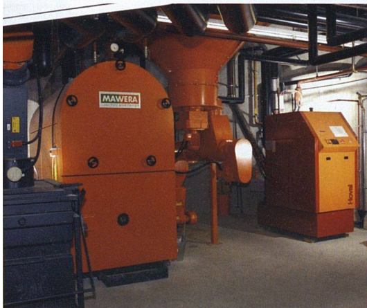
Bei der Siedlung Vistaverde (BG Freiblick und Zurlinden) heizt man mit Holzschnitzeln. Solarzellen übernehmen einen Grossteil der Warmwassererwärmung.
