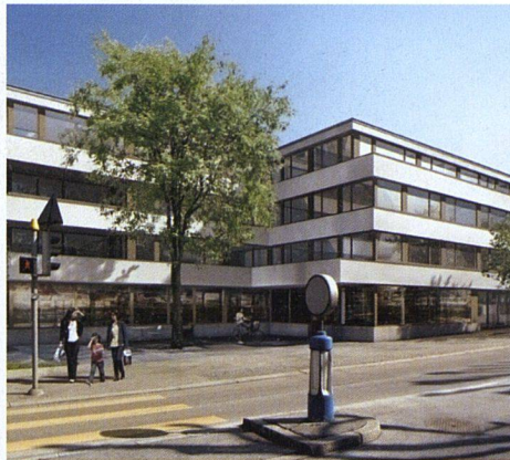
Die Siedlung «Lienihof» von Architekt Adrian Streich wird noch diesen Herbst bezugsbereit. Mit dem Ersatz der ehemaligen Schreinerei Lienhard in Wollishofen entstehen 32 Wohnungen in einem eher gehobenen Segment.
