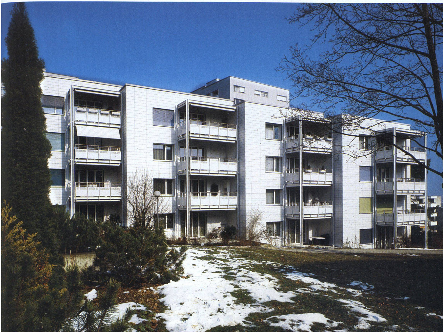
Rund 240 000 Franken pro Wohnung investierte die Baugenossenschaft Frohheim bei der Sanierung ihrer Siedlung Suteracher V in Zürich Altstetten. Die 70er-Jahr-Blöcke erhielten eine neue hinterlüftete Fassade, Kleinwohnungen wurden zusammengelegt, Küche und Bad ersetzt.
