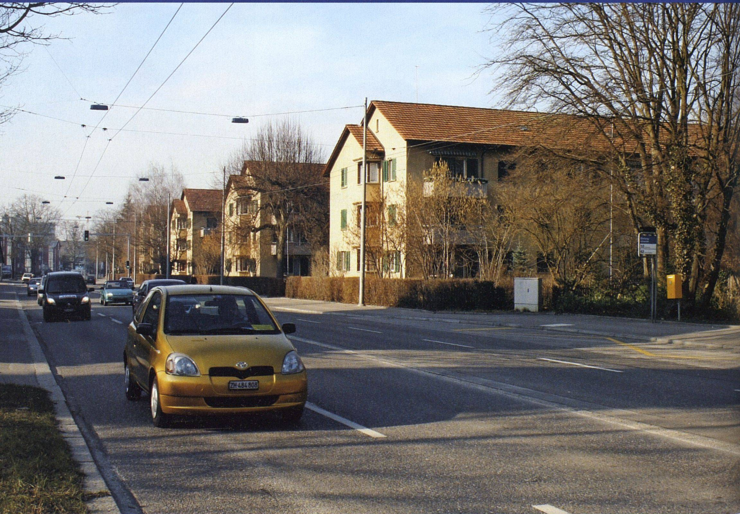
In Zürich Affoltern ersetzt die Baugenossenschaft Frohheim eine 1945/46 erstellte Siedlung mit zehn Mehrfamilienhäusern und 36 Reihenhäusern durch Neubauten.
