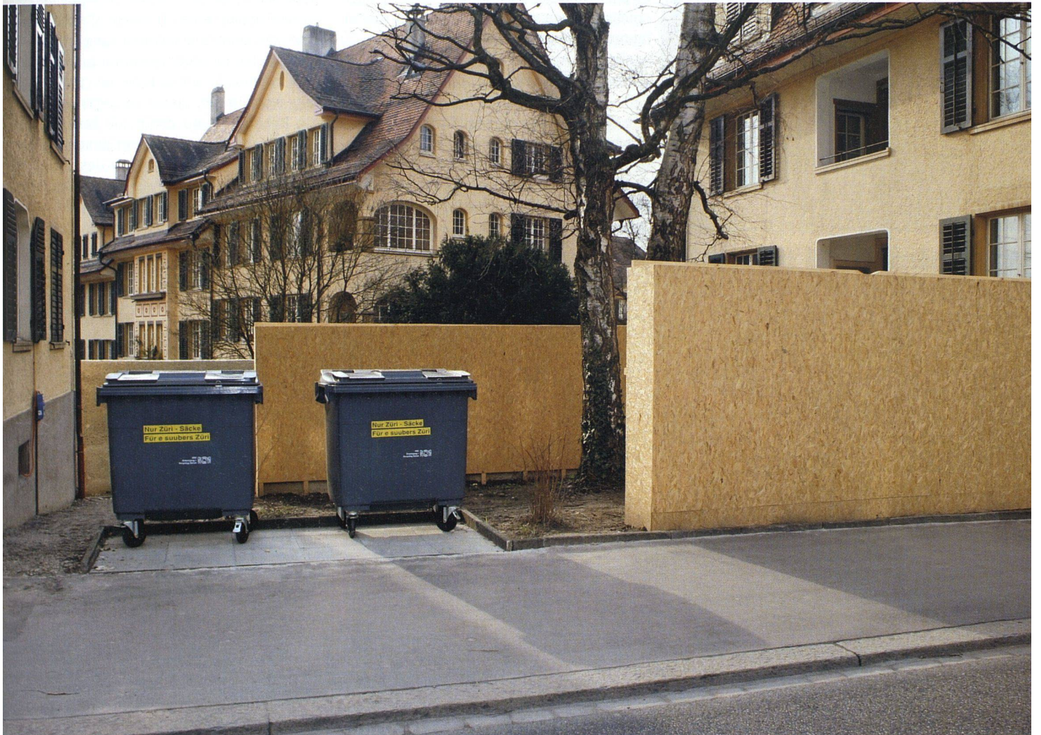
Mehrere versetzt angeordnete Scheiben schützen die Hofräume der städtischen Siedlung Riedtli in Zürich vor dem Verkehrslärm der Winterthurerstrasse.
