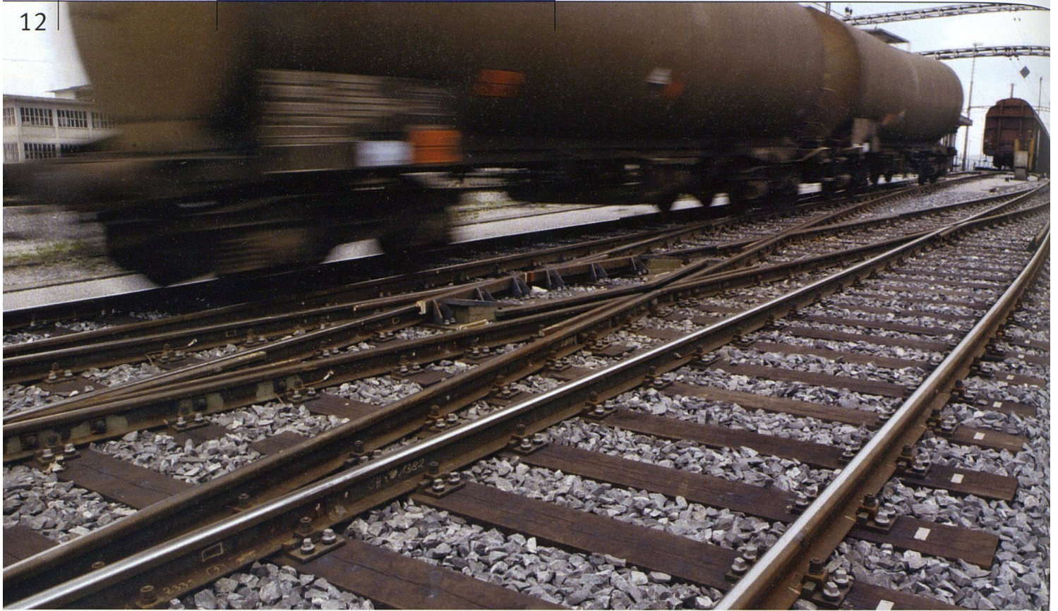
Die Bahn ist punkto Vollzug der Lärmschutzverordnung (LSV) am weitesten. Sie setzt auf Schutzwände und technische Verbesserungen beim Rollmaterial.
