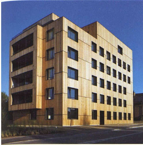
Vor- und Rücksprünge, Lochfenster und erkerartig ausgebildete Balkone prägen die abstrakte Gestalt des Gebäudes. Als Kontrast dazu die bewusst zur Schau getragene Holzverkleidung.
