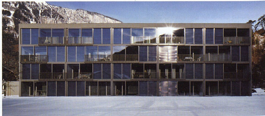
Die Nutzung der Sonnenwärme ist ein Gebot der Stunde. Bei den Alterswohnungen in Domat/Ems (vgl. wohnen 5/05) schützt ein Spezialglas gleichzeitig vor Überhitzung.
