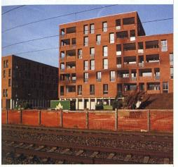
Die ABZ-Siedlung Ruggächern liegt an einer Bahnlinie. Aus Gründen des Schallschutzes ist eine doppelschalige Fassadenkonstruktion hier sinnvoll.
