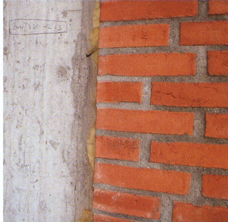
Solide Konstruktion: Beton- und Klinkerschale mit dazwischenliegender Dämmung.
