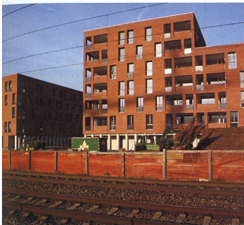
Die ABZ-Siedlung Ruggäbern liegt an einer Bahnlinie. Aus Gründen des Schallschutzes ist eine doppelschalige Fassadenkonstruktion hier sinnvoll.
