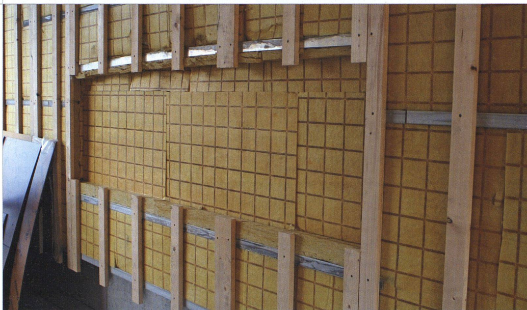
Eine neue Studie zeigt: Die Mehrkosten grösserer Dämmstärken zahlen sich über die gesamte Lebensdauer eines Gebäudes aus.
