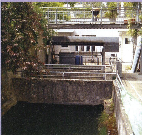
Das Kleinwasserkraftwerk der Siedlung Hard in Winterthur Wülflingen erzeugt Ökostrom für etwa 400 Haushalte.
