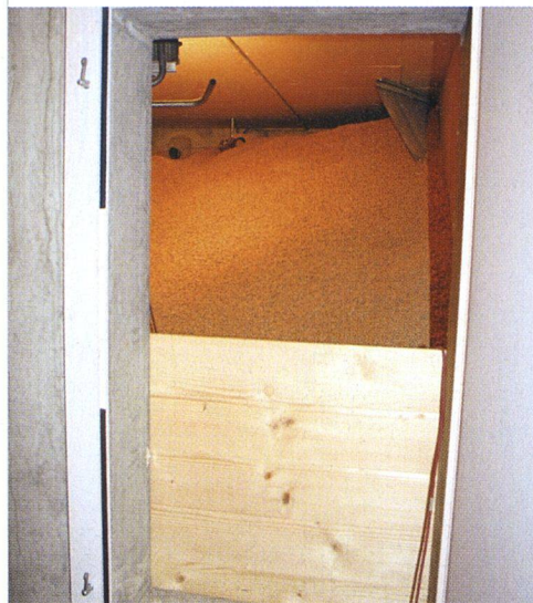
Im Lagerraum finden 45 Tonnen Pellets Platz, die der Feuerung automatisch zugeführt werden.
