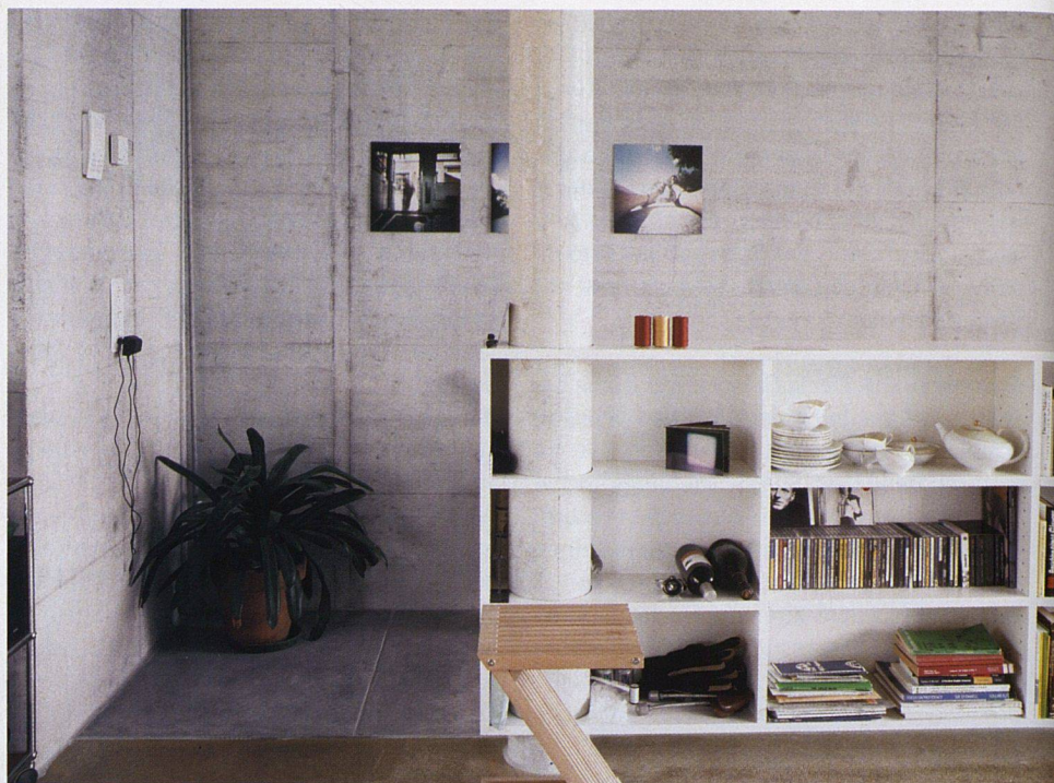
Eine selten gewählte Lösung: Die Wände einfach nicht verputzen. Die Genossenschaft Dreieck entschied sich bei ihrem Zwischenbau aus dem Jahr 2003 für Sichtbetonwände.
