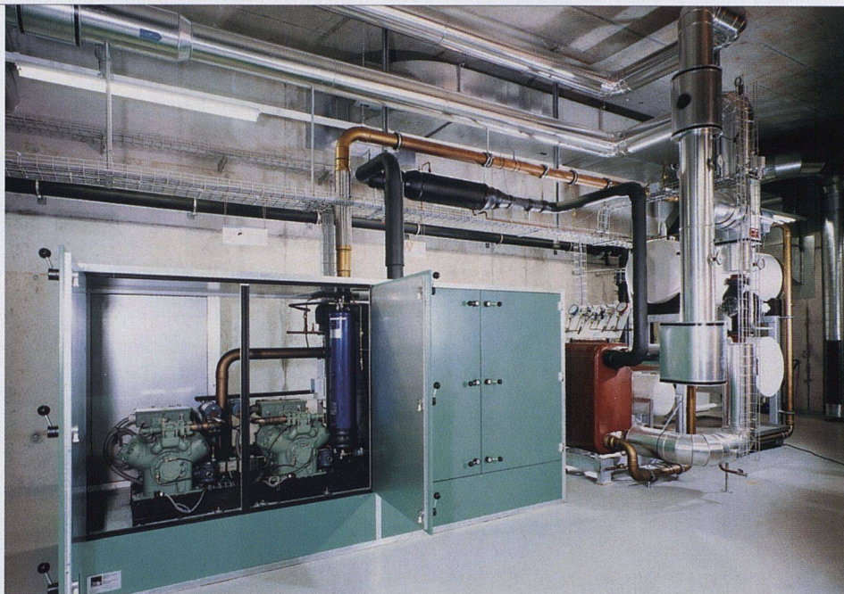
Grosswärmepumpen nutzen die Abwärme aus Grund-, Abwasser oder aus dem Erdreich.
