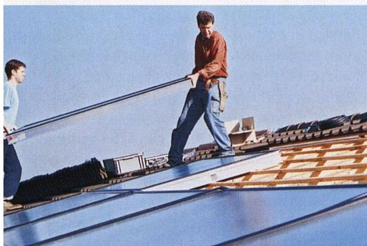
deutlich unter einem Jahr. Gegenüber herkömmlichen Streifenkollektoren sorgt die neue Absorberoberfläche für ein ruhiges und gleichmässiges Erscheinungsbild. Die Kollektoren eignen sich für Indach-, Aufdach- und Flachdach-Montage.
