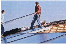
deutlich unter einem Jahr. Gegenüber herkömmlichen Streifenkollektoren sorgt die neue Absorberoberfläche für ein ruhiges und gleichmässiges Erscheinungsbild. Die Kollektoren eigen sich für Indach-, Aufdach- und Flachdach-Montage.
