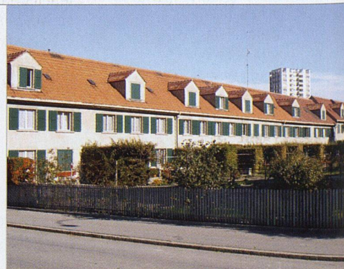
Die Ein- und Zweifamilienhäuser aus dem Jahr 1918 konnten der lärmigen Ringstrasse nicht mehr trotzen.
