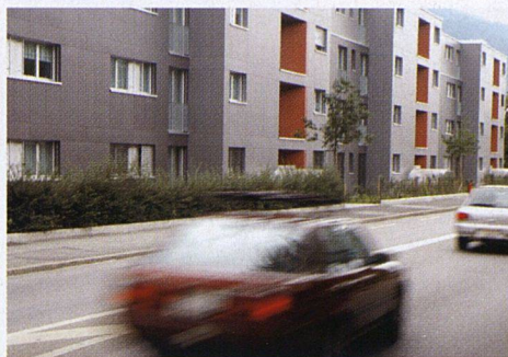
Die Lärmsituation an der stark befahrenen Ringstrasse verlangte eine gute Isolierung und eine mechanische Lüftung. Damit war bereits der Weg für den Minergie-Standard vorgegeben.
