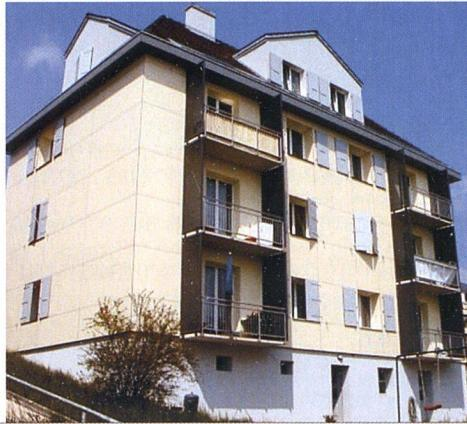
**Das Mehrfamilienhaus «Bâtiment locatif» in Neuenburg wurde nach dem Minergie-Standard saniert. Die Energiebezugsfläche von 587 m<sup>2</sup> wird mit einer Gasfeuerung beheizt. Für eine solche Sanierung schüttet das Gebäudeprogramm der Stiftung Klimarappen einen Förderbetrag von rund 25 000 Franken aus.**
