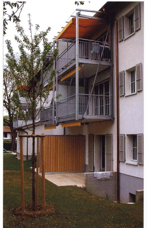
Die vorher in einer Nische versenkten Balkone wurden ganz nach aussen versetzt, so dass mehr Wohnfläche entstand. Die neuen Balkonkonstruktionen bieten zehn Quadratmeter Fläche. Wegen der Sonderbauvorschriften mussten sie über zwei Stockwerke aufgehängt werden.
